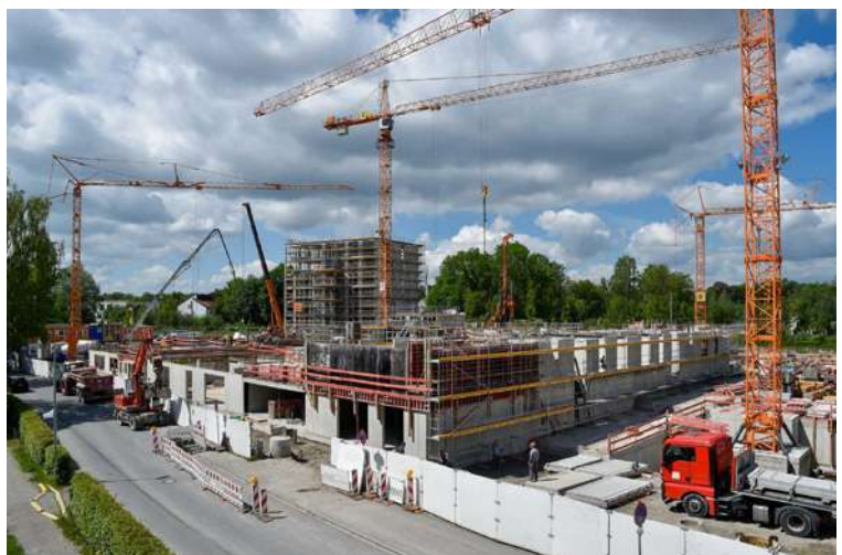
Baustelle im Mai 2020
